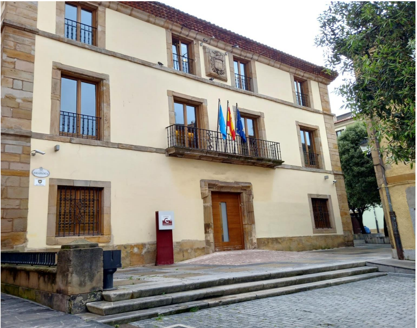
Fachada frontal de la Casa de Nava, C/Salamanca núm. 1
